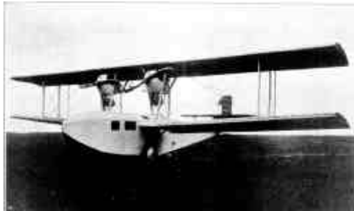
Le premier LeO H-13 à moteurs Hispano-Suiza de 150 ch (1922). (Cliché A. Delmas).
