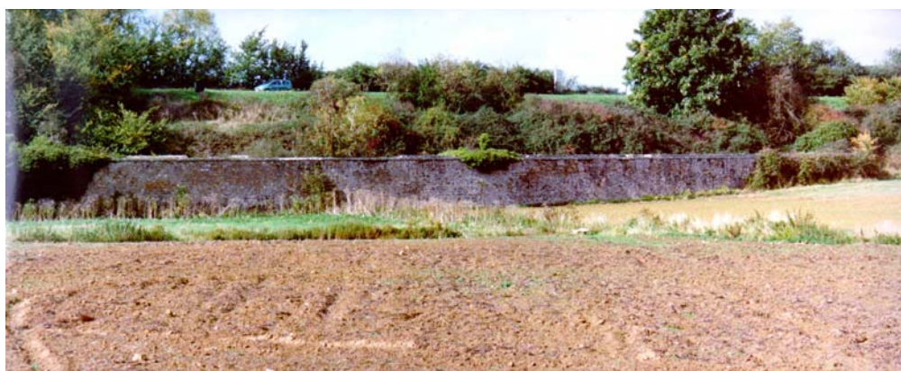
État actuel de l'aqueduc aérien du Trou Salé à l'est de la RD 938. (photo P.Bessas)
